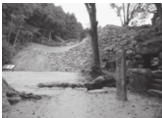
△修復された基肄城水門跡
