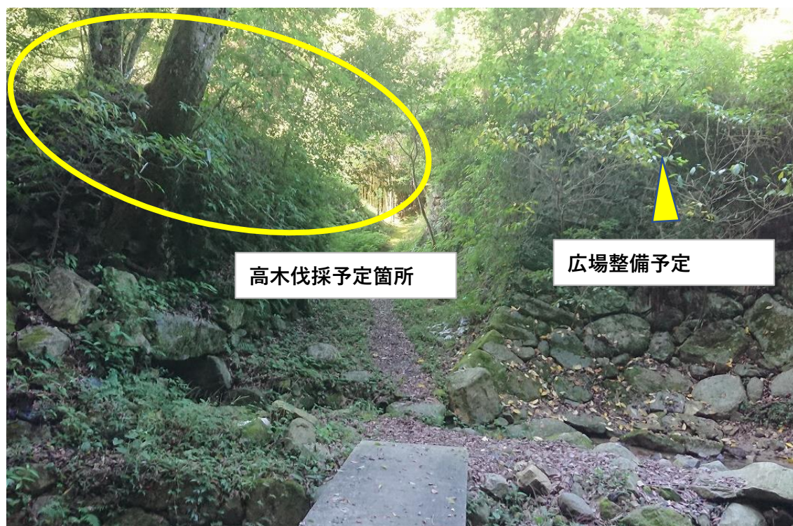
①南門跡石塁周辺高木伐採箇所（東から）
