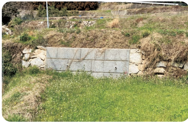
農地石垣崩落災害の災害復旧工事
