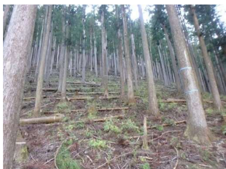
図 77. 伐採木を活用した土留め
