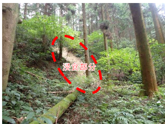
図 51. 大規模な法面浸食の例
