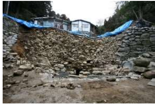
図 12. 水門石垣解体調査（平成 25 年度）
