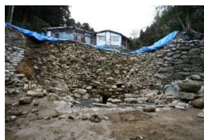
水門石垣解体調査（平成 25 年度）
