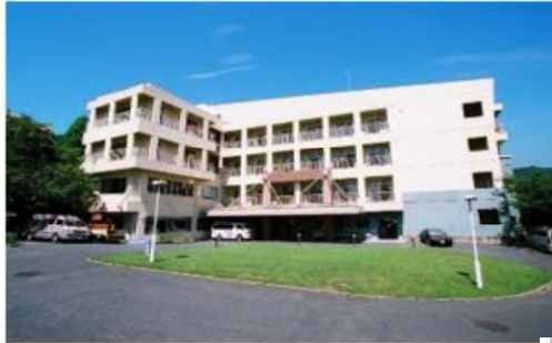
老人保健施設あおぞら外観 基山町
