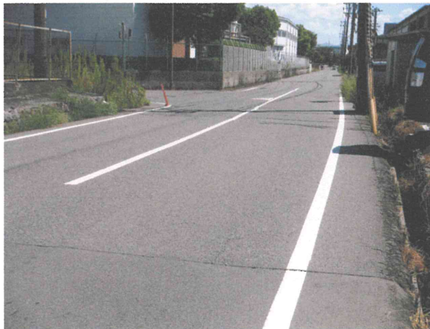
④ ②付近から東側に向かったの写真
