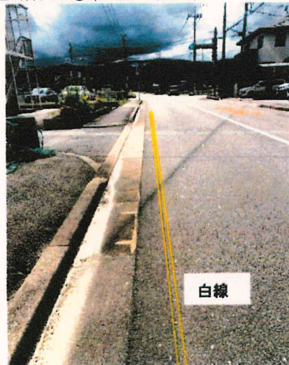
道路標識④(白線の補修)
