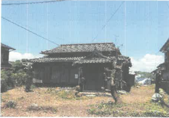
• 現地写真（撮影月：2021.7）
