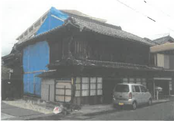
・現地写真（撮影月：2020.11）
