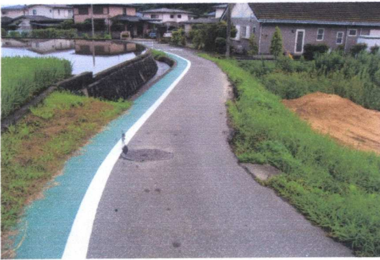
・北側から見た状況
