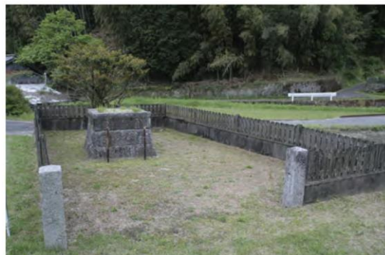
みこしあつめ(劣化が進行)
