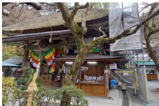
本堂写真(工事中)
