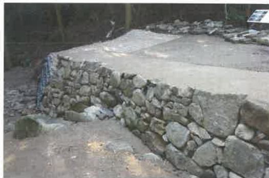
災害復旧工事状況(水門下流部護岸 着手後)
