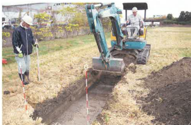
埋蔵文化財有無の確認のための調査(三川下遺跡)
