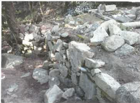
災害復旧工事状況(水門下流部護岸 着手前)
