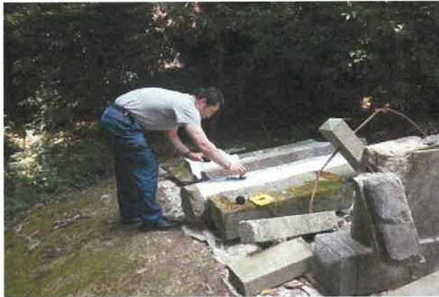
現地作業状況
