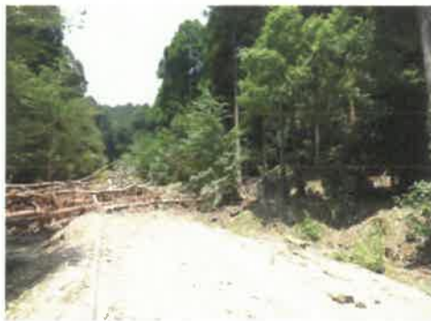
豪雨災害で通行不能となった散策路
