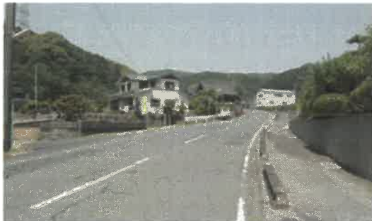
劣化した御神幸祭の道
