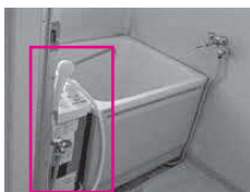
風呂釜・浴槽 の設置
