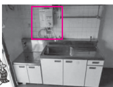
キッチン 湯沸器の設置
