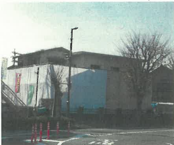
(対応後) ※12月9日に撮影。建物を解体中。
