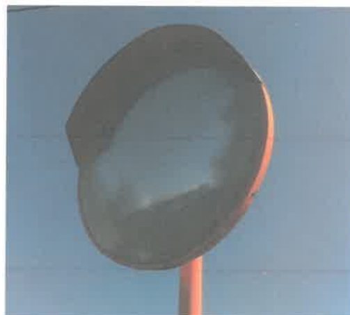
図 3 錆びたカーブミラー
