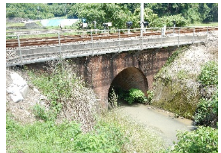
写真 三国煉瓦アーチ橋
