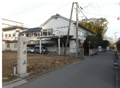
写真 西海製薬社屋(現況)
