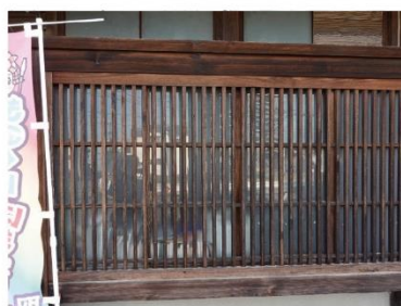
○ 縦格子の設置 (1階沿道箇所)
