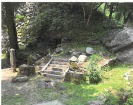
現地写真(保存修理前)
