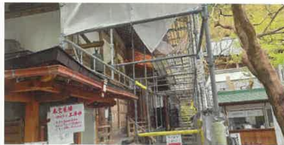
本堂写真(保存修理中)
