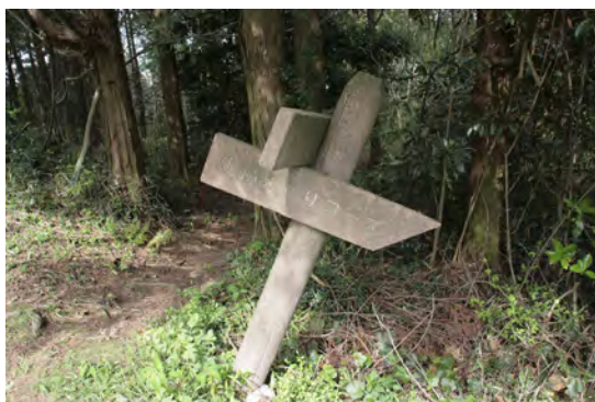
写真 劣化したサイン
