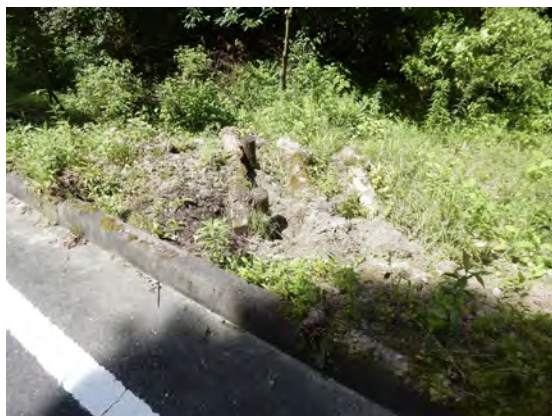
写真 基肆城内獣害（イノシシが掘り起こした階段）
