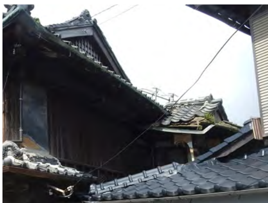
写真 瓦が脱落している住宅
