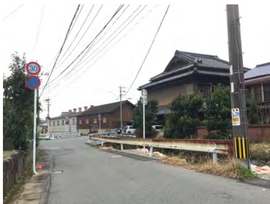
写真 長崎街道沿いの劣化したガードレール
