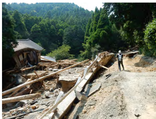
写真 町道丸林線崩壊
