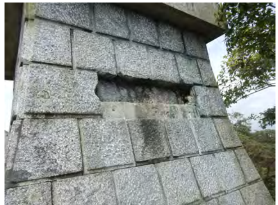
写真 天智天皇欽仰之碑銘板欠損
