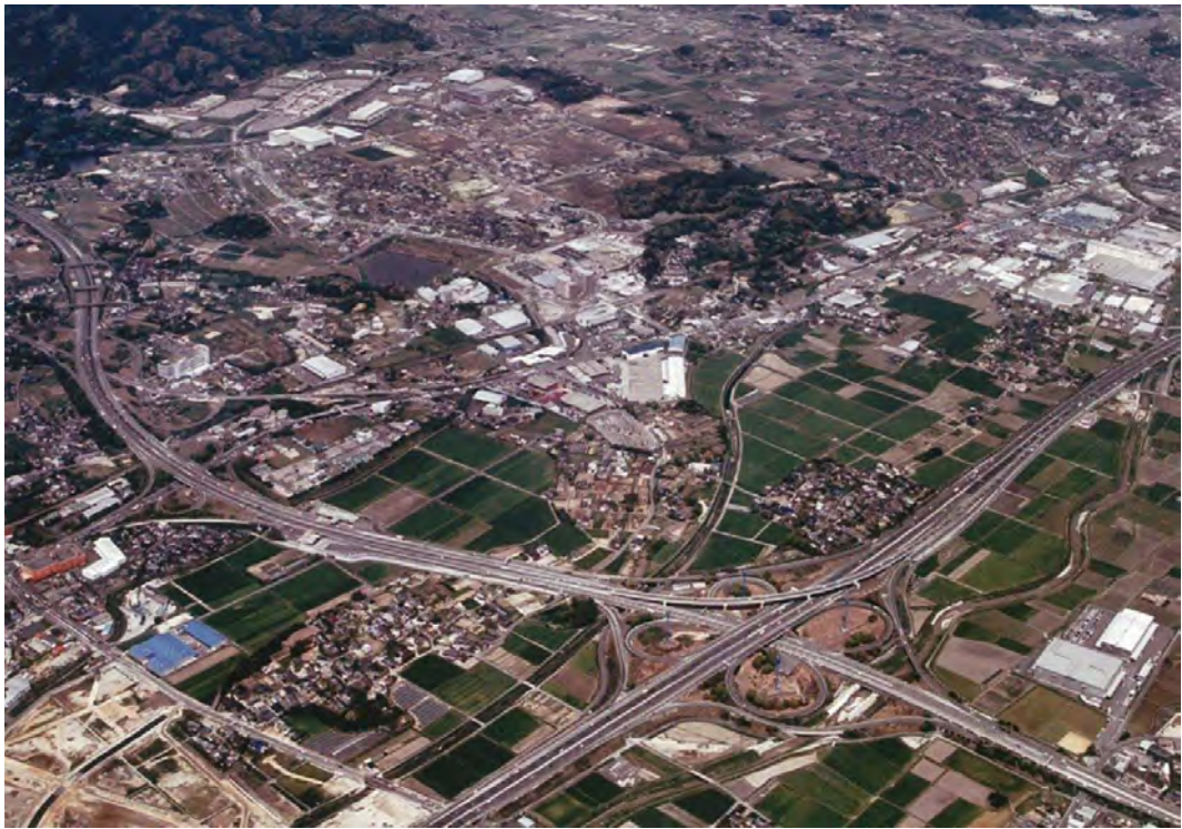
写真 鳥栖ジャンクション
