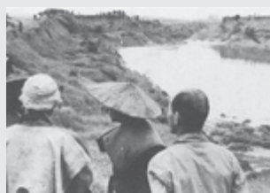
昭和 28 年 亀の甲ため池 堤防決壊
