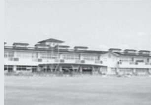
平成 21 年 基山小学校新校舎完成
