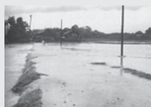
昭和 38 年 豪雨災害 (高島付近)
