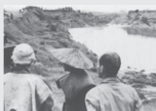
昭和 28 年 亀の甲ため池 堤防決壊
