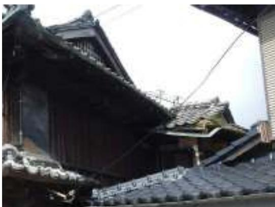
写真 瓦が脱落している住宅
