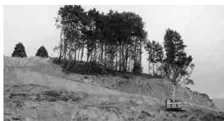
▲工事が進む温泉施設「山楽」
