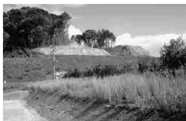
▲造成中の温泉施設
