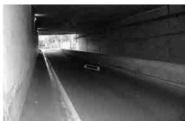
▲暗くて狭い高速道路ボックス
