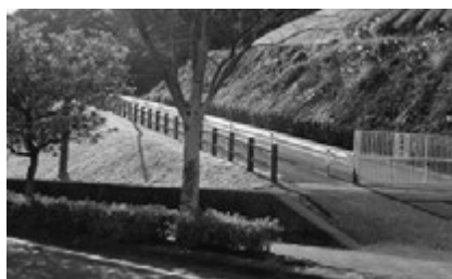
▲けやき台四丁目北側法面の一部
