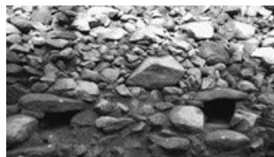
▲水門石垣から見つかった通水溝
