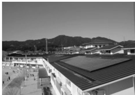
▲基山小学校の30kW太陽光発電
