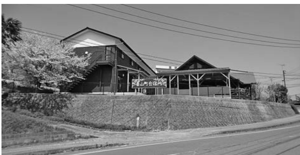
▲完成間近の基山町合宿所
