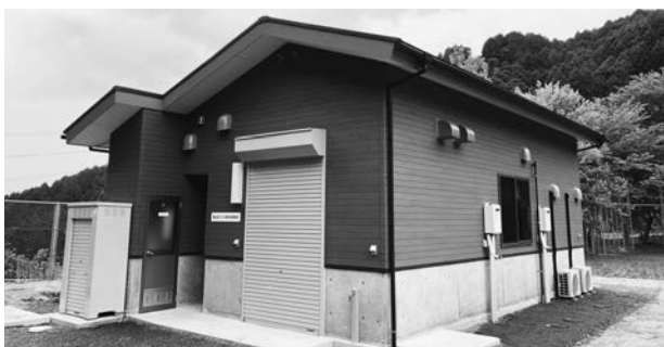
▲完成したジビエ解体処理施設
