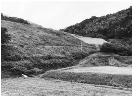
▲亀の甲ため池ののり面崩壊
