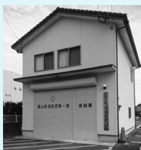
▲消防団第一格納庫
