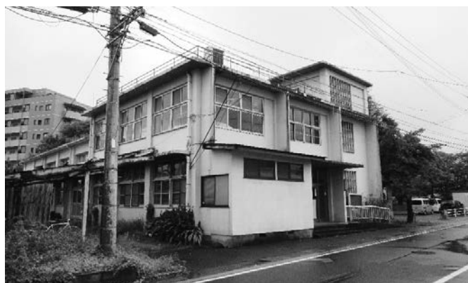
▲取り壊される旧中央公民館
