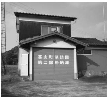
▲町が管理すべき消防格納庫
