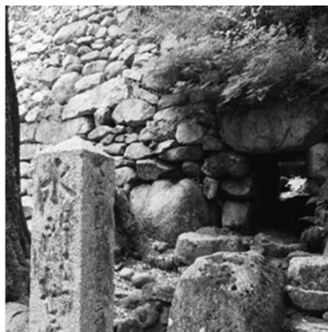
▲修復された水門跡
