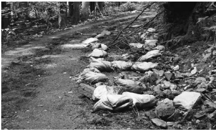
▲未整備の町道
