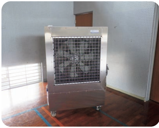
小中体育館に設置される大型気化式冷風機
