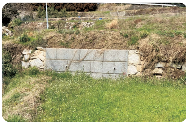
農地石垣崩落災害の災害復旧工事
