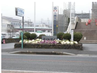
改装工事中の市川町役場
