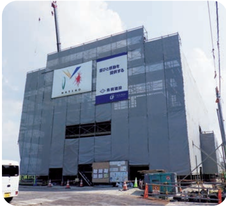
来年稼働の建設中の污水ポンプ場
