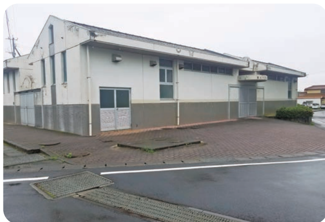
解体が決まった中学校プール
