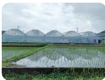
優良企業の誘致を期待 (建設中のいちご農園)
