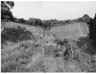
▲土砂災害を防ぐ砂防ダム
