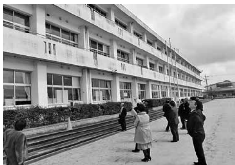
▲老朽化が進む基山中学校
