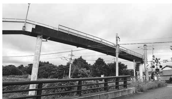
▲老朽化が進む白坂歩道橋
