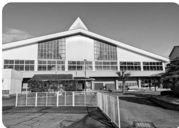
補修が続く中学校体育館
