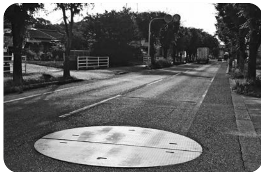
下水道工事が始まる県道本郷基山線
