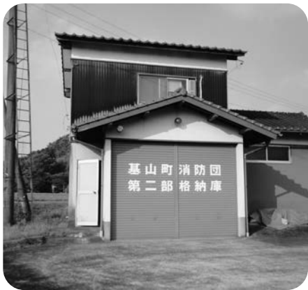
町が管理すべき消防格納庫
