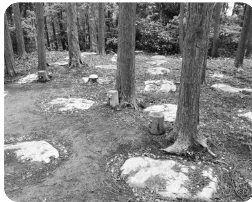
礎石群を侵食する樹木
