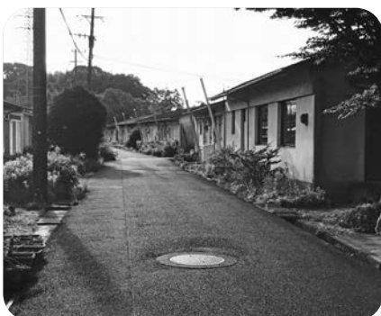
建設から50年を過ぎた園部団地
