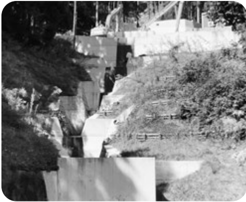
整備が進む治山ダム
