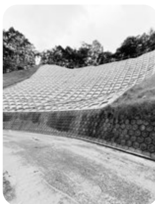
崩落現場の復旧工事完了
