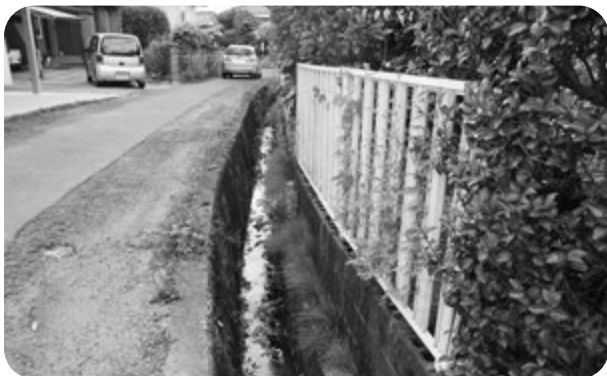
危険な町道長野1・2号線
