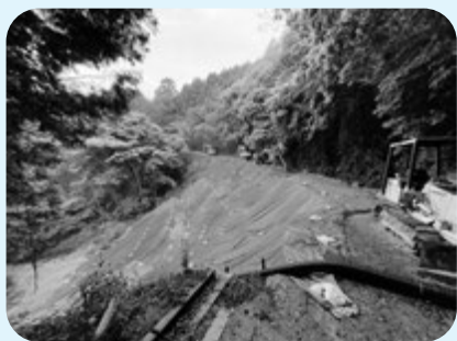
復旧中の崩落現場
