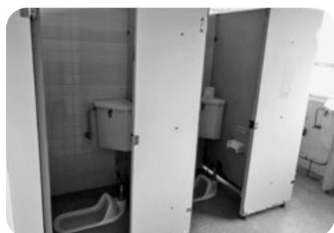
若基小学校体育館トイレ改修（洋式化）
