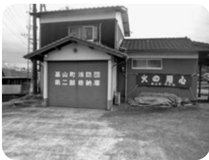
町が管理すべき消防格納庫
