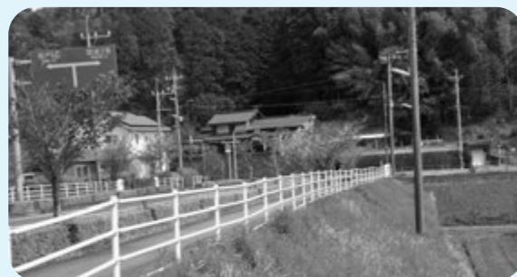
町道に接する、のり面
