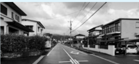
園児が利用する高島団地内道路
