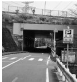
拡張工事が始まる高速下のボックス
