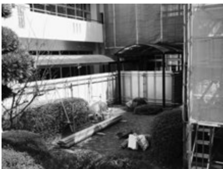
エレベーター・スロープの設置箇所
