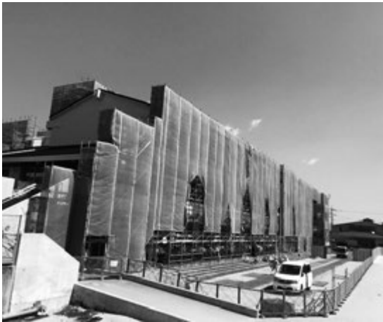
6月完成予定の基山中学校大規模改造工事
