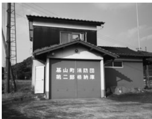
町が管理すべき消防格納庫
