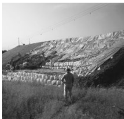
復旧が待たれる亀の甲ため池
