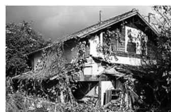
▲除去された不良住宅
