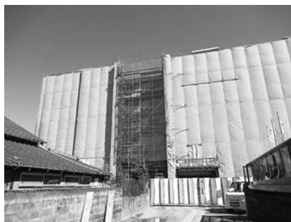
▲アモーレ・グランデ基山建設現場
