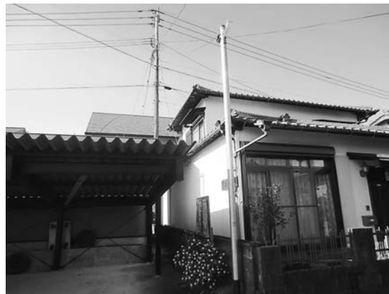
▲最近設置された防犯灯
