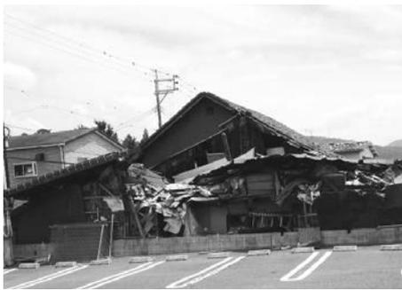
▲熊本地震で倒壊した木造建築物
