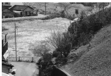
▲ブロック積工事現場
