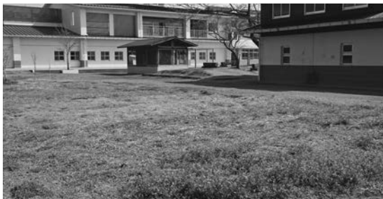
▲基山小敷地内に平屋建てを併設予定
