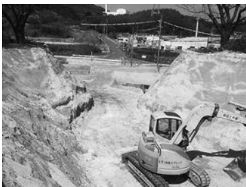
▲白坂久保田2号線改良工事 基山サービスエリアを望む
