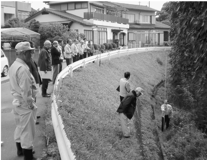
▲神の浦ため池現地調査
