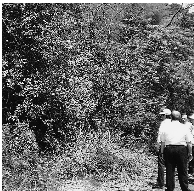
▲寺谷林道崩落現場
