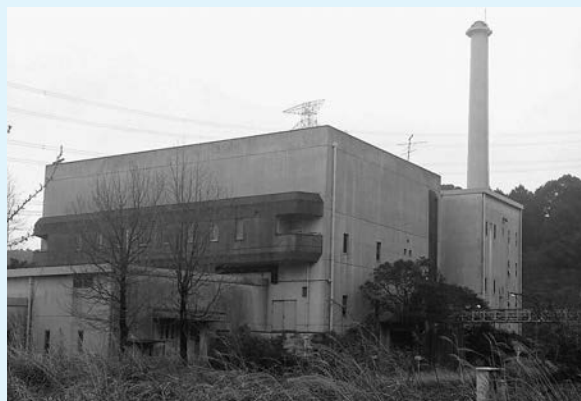
▲解体予定の旧施設
